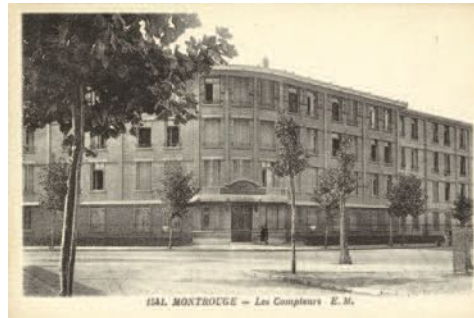
La compagnie des compteurs, site de Montrouge
