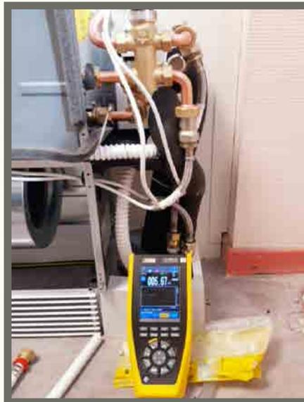
Medida con pinza de corriente de fuga y registro del defecto.
