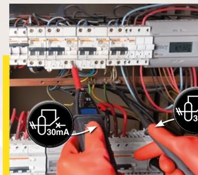
Entre la phase et la terre, l'**appui simultané sur la double commande** permet de faire circuler au travers d'une charge basse impédance un courant de défaut nécessaire au déclenchement du différentiel.
