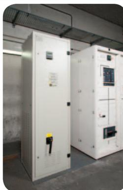
Lors de la mise en service de l'armoire, cette dernière a permis de réduire la puissance réactive consommée par l'installation. Sur cet enregistrement (voir Fig. 4), la puissance réactive revient à un niveau négligeable, proche de 0. La consigne du  $\cos \varphi$  est amenée à 1 (voir Fig. 5).
