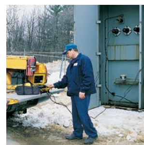
In campo, misura su trasformatore trifase 2000 Kva
