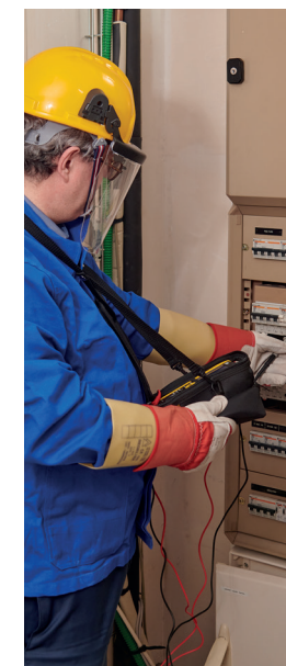
Sterowanie szafą elektryczną
