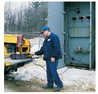
Vor-Ort-Prüfung eines 2000 kVA-Drehstromtransformators
