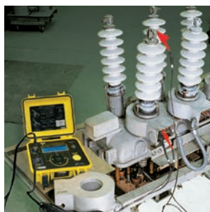
Mesure du rapport d'un transformateur de courant
