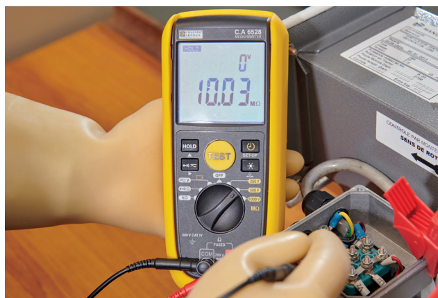
Preventivní údržba elektromotoru
