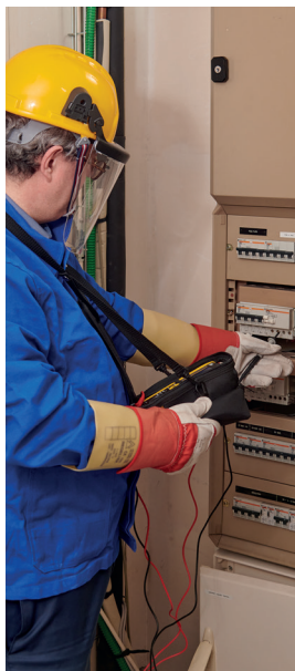
ovládání elektrické skřínky
