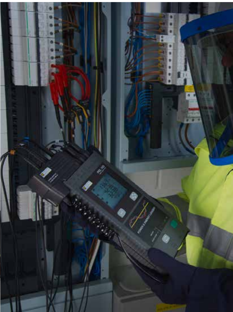
Leistungs- und Energie-Recorder (PEL100)
