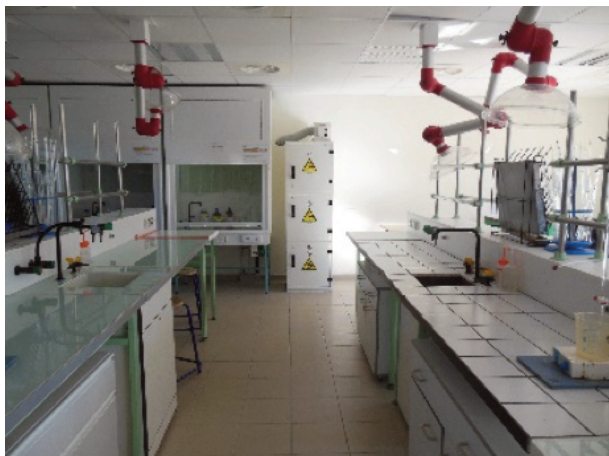
Vue intérieur avec au fond les sorbonnes et au premier plan les bras d'aspiration individuels
