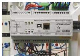
Système de délestage de charges électriques installé dans le tableau électrique. L'Optilesteur permet de limiter sous un seuil fixé, la puissance d'appel d'équipements électriques chez le client, grâce à un effet de délestage cyclique du fonctionnement des différents équipements. Le délestage n'affecte théoriquement pas le confort du client et son fonctionnement lui est transparent.
